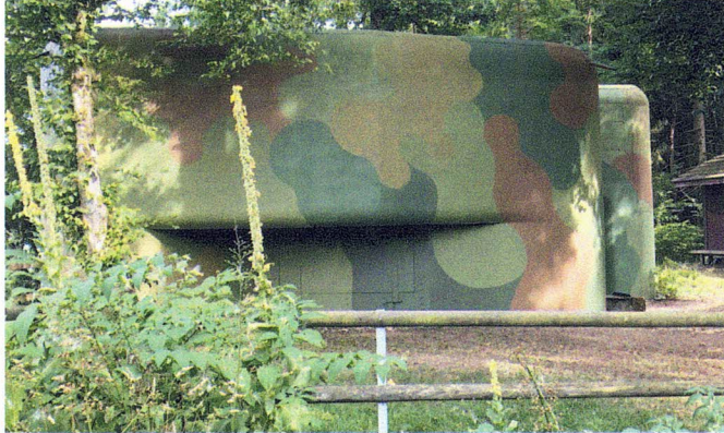
Bunker «Bruggechopf» Das Werk gehörte zur Werkkompanie 41 der Grenzbrigade 6
